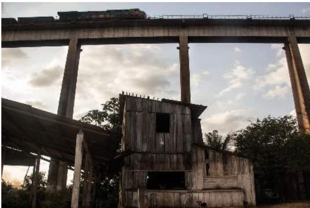
Estrada de Ferro Carajás passando nas proximidades das casas dos habitantes em Piquiá de Baixo. ©Marcelo Cruz
