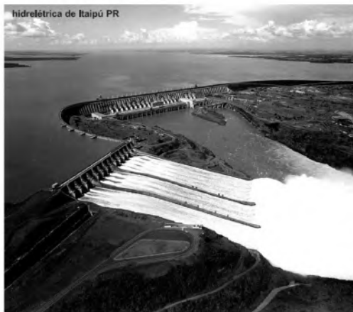
hidrelétrica de Itaipu PR
